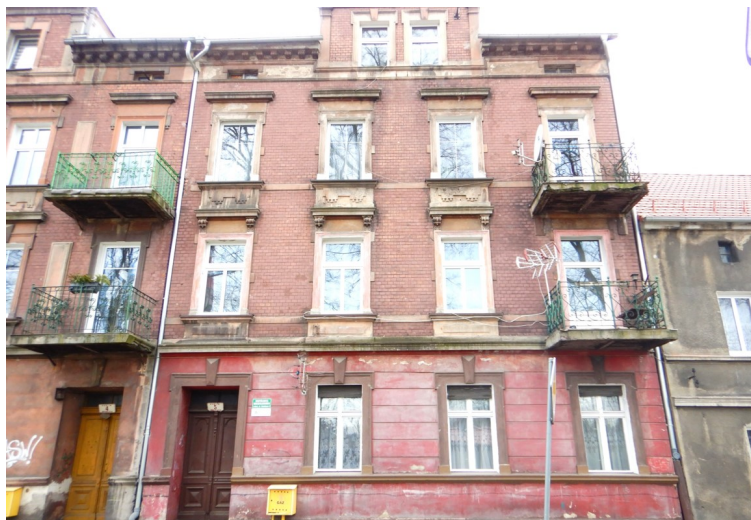
Ogólny widok budynku
